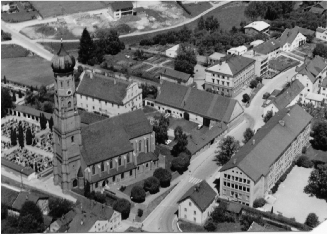
Aufnahme 1967. Pfarrhaus, Pfarrhof mit Ökonomiegebäuden. (AHV) Der Pfarrstadel, Pferdestall und die Wagenremise wurden im Mai 1970 abgebrochen. Im Vordergrund rechts steht der im März 1956 eingeweihte Neubau der Grundschule. Dahinter links, das Mädchenschulhaus, erbaut 1892/93, abgebrochen 1982.
